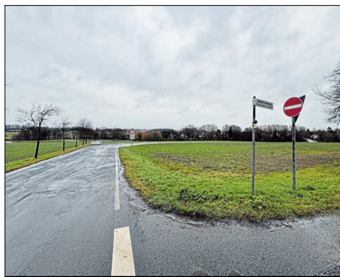
Die Großwelkaer Straße soll zwischen Gerbersiedlung und Durchlass Kleinwelkaer Wasser umfangreich saniert werden. Foto: ksl
