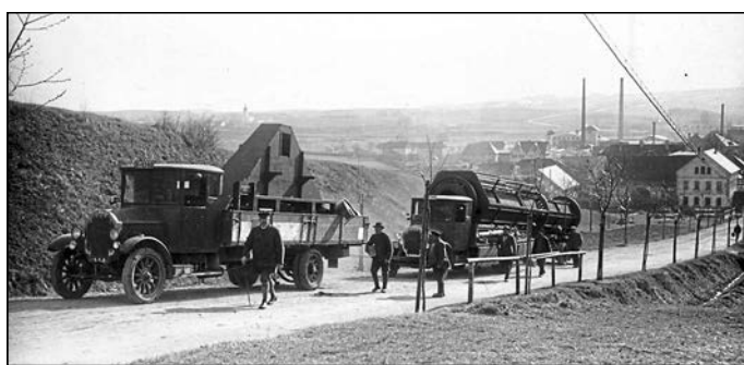
Transport der neuen Siebanlage zum Steinbruch „Alter Hutberg“ in der Bernstädter Straße in Ostritz um 1928 Sammlung Tilo Böhmer
