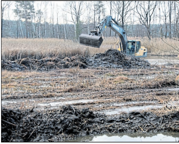
Bei den Arbeiten am Froschteich
