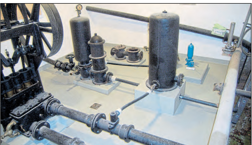
Die historische Hebeanlage von 1905 „Hydraulischer Widder“ wird sachkundig vorgeführt und erläutert. Foto: Verein
