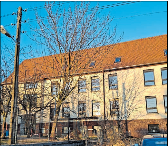
Der Kita-Bereich muss vollständig beräumt werden, der Krippenbereich ist nicht betroffen.
