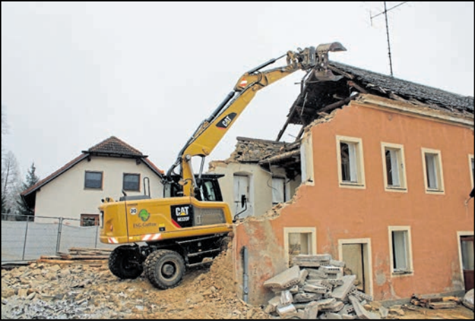
Der Abriss der Funktionalbauten beinhaltete die Beräumung und Entkernung. Foto: Stadtverwaltung Kamenz
