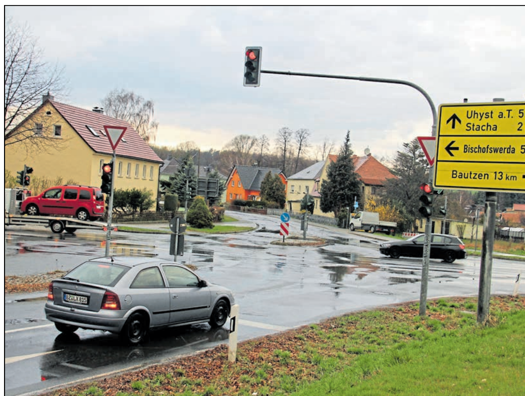
Die Wölkauer Kreuzung wird bis Ende November ausgebaut, einschließlich der Erneuerung der Ampelanlage. Foto: Carmen Schumann
