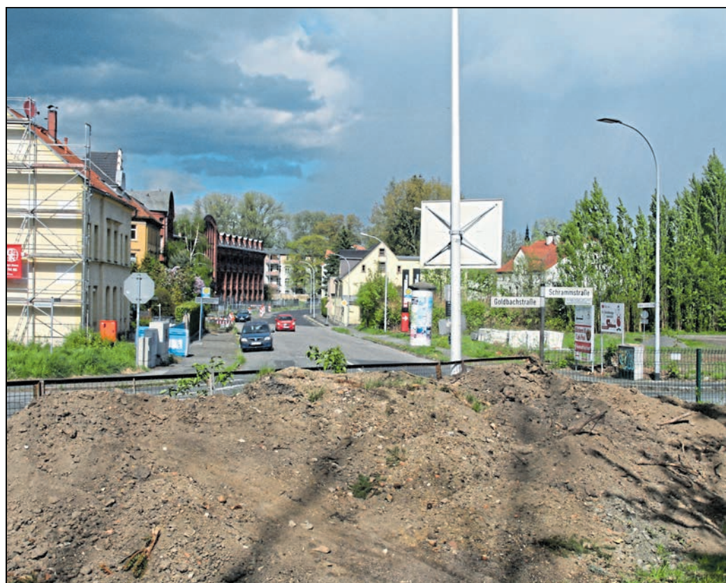
Am Knotenpunkt Schrammstraße, Äußere Oybiner Straße, Goldbachstraße in Zittau beginnen die Arbeiten für den neuen Kreisverkehr. Foto: Steffen Linke
