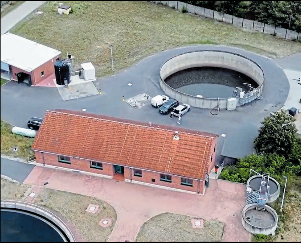
Durch die örtliche Lage der Kläranlage, fernab von jeglicher Wohnbebauung, würde ein Brand oder eine Rauchentwicklung nicht oder erst sehr spät bemerkt werden.
