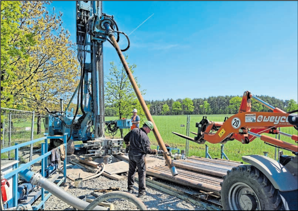
Gegenwärtig wird im Wittichenauer Stadtteil Hoske die insgesamt zweite Bohrung in das Erdreich getrieben.
