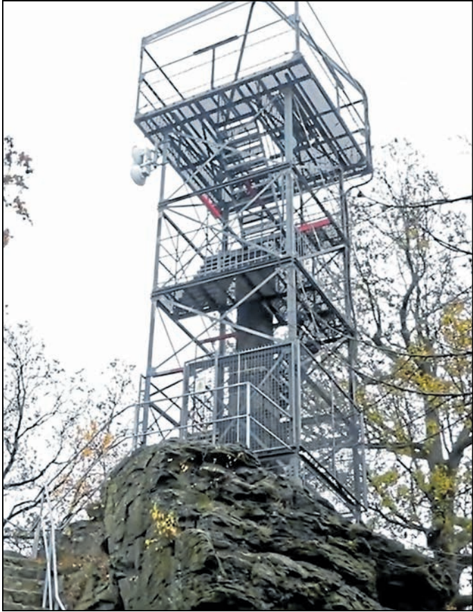
Erbaut wurde der Turm vom Oberlichtenauer Mühlenbaumeister Wilhelm Franke.
