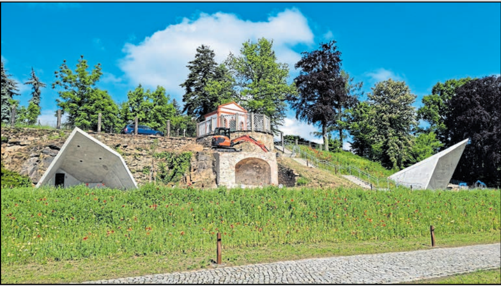
Panschwitz-Kuckau. Wo früher die zwischenzeitlich abgerissene Gaststätte zu Tanz und Geselligkeit einlud, wurde vor wenigen Tagen die neu errichtete PaKu-KommunikationsArena eingeweiht. „Mit viel Engagement hat die Gemeinde Panschwitz-Kuckau dieses Projekt realisiert – ein starkes Zeichen für gelebte Gemeinschaft und zukunftsorientierte Regionalentwicklung“, erklärt das Sächsische Landeskuratorium Ländlicher Raum. Die Idee, das Areal zu einer generationenübergreifenden Begegnungsstätte umzugestalten, wurde im simul+ Mitmachfonds 2021 mit 100.000 Euro prämiert. Den Hauptblickfang bilden zwei futuristisch gestaltete Pavillons als kulturelle Treffpunkte, hinzu kommen ein Festplatz auf dem terrassenförmigen Gelände sowie ein Spiel- und Bewegungsplatz für Kinder und Erwachsene. E-Bike-Fahrer haben die Möglichkeit, die Akkus ihrer Stahlrösser aufzuladen.(UM)
