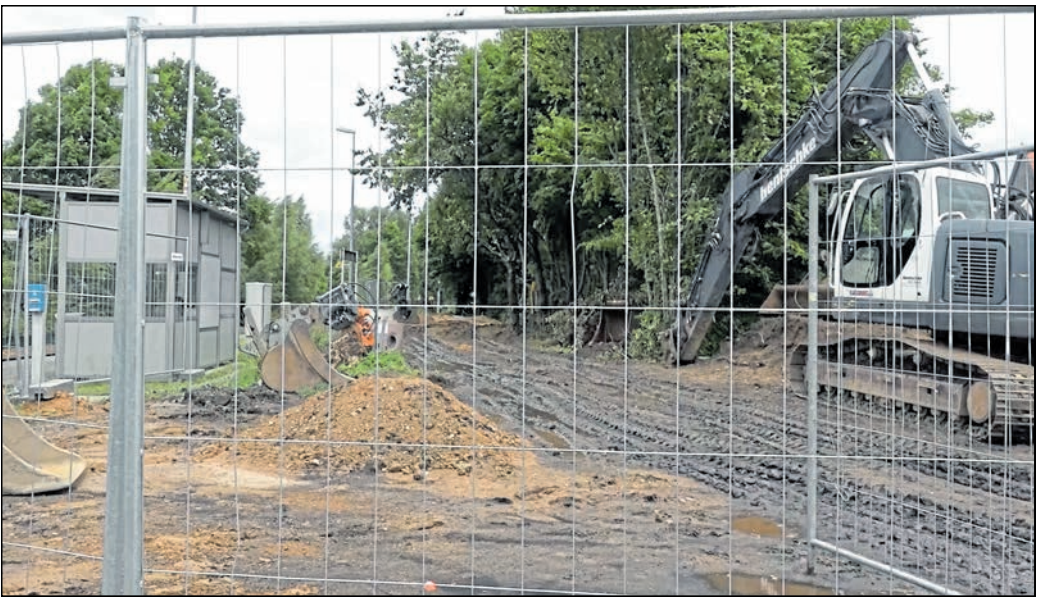
Grund für die Einschränkungen sind Bauarbeiten für einen neuen Bahnsteig am Haltepunkt Bischoheim-Gersdorf.
