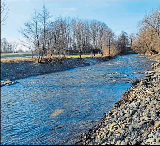
Die Mandau erhielt im Bereich Pethau ihre natürliche Gewässer- sohle zurück. Foto: Landestalsperrenverwaltung Sachsen
