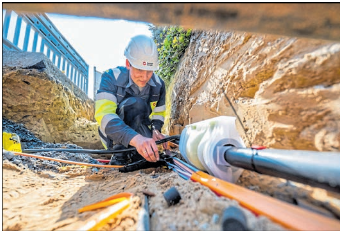
Gesundbrunnen und Allende-Viertel: Der digitale Anschluss ist da Foto: SachsenEnergie
