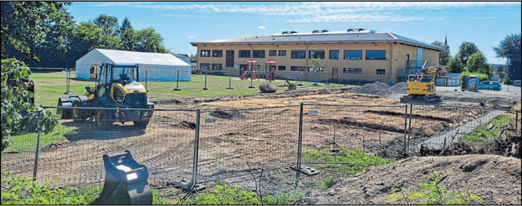
Auf dem Ralbitzer Schulgelände haben die vorbereitenden Arbeiten für den Neubau eines Hortgebäudes begonnen.
