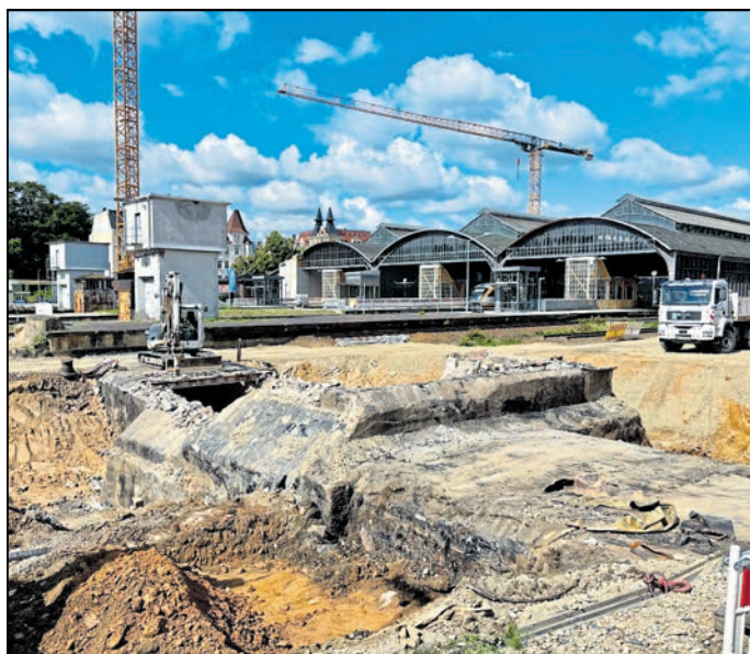
Die aktuellen Arbeiten legten den einstigen Posttunnel am Görlitzer Bahnhof nun wieder frei. Foto: Matthias Wehnert
