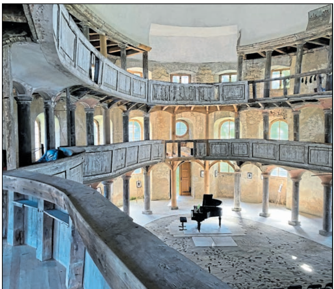
Auf diesem Foto ist in der Kirche von Giersdorf der neue Bodenbelag noch nicht gelegt. Foto: Till Scholtz-Knobloch
