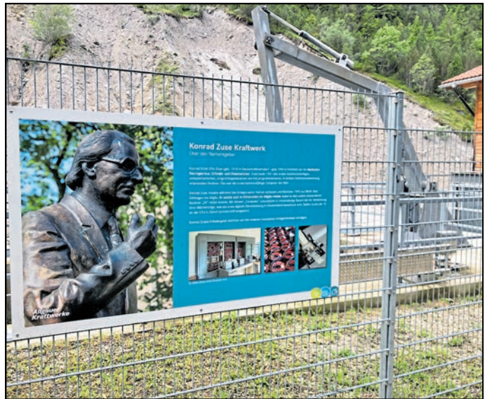
Zwischen Hinterstein und Bad Hindelang wird durch das Wasser der Ostrach, einem Nebenfluss der Iller, Strom im „Konrad-Zuse-Kraftwerk“ gewonnen. Foto: Till Scholtz-Knobloch
