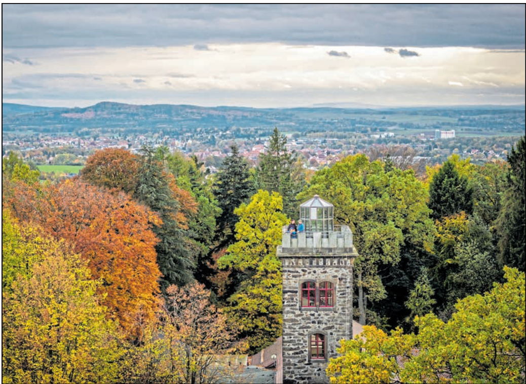
Nach den Plänen von Carl August Frenzelder entstand auf dem Butterberg in Bischofswerda der 21 Meter hohe Turm und das Gasthaus aus heimischem Granit und elbischem Sandstein. Foto: Philipp Herfort
