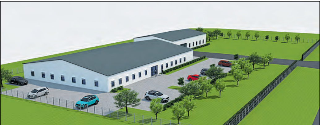
Durch den Einsatz erneuerbarer Energien und energieeffizienter Prozesse wird der Treibhausgasausstoß deutlich reduziert. Visualisierung: Liofit
