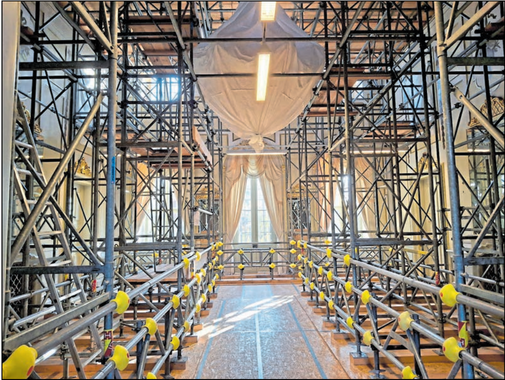
Auch mit seiner derzeitigen Sicherheits-Rüstung sieht der Spiegelssaal imposant aus, ist aber für seinen eigentlichen Zweck nicht nutzbar.
