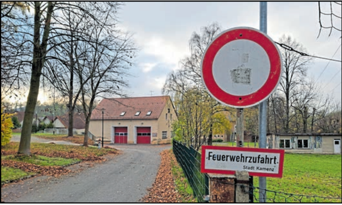
Vorbereitende Arbeiten für das neue Gerätehaus werden bereits Anfang 2025 beginnen.
