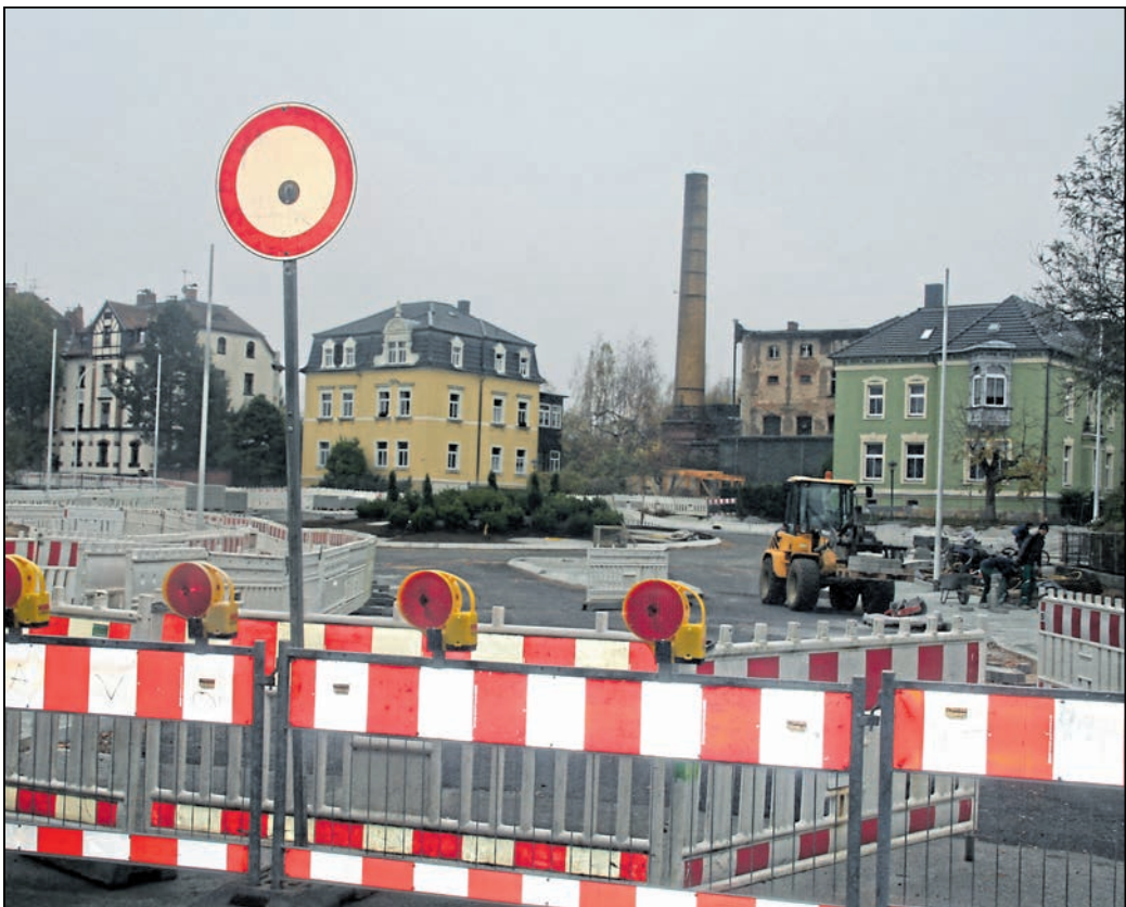
Die Baustelle am Knotenpunkt Goldbachstraße, Äußere Oybiner Straße und Schrammstraße in Zittau ist durch ein Labyrinth an Bauzäunen abgesperrt. Foto: Steffen Linke
