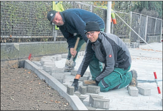
Bauarbeiter verlegten hier in der Goldbachstraße gerade die letzten Gehwegplatten. Foto: Steffen Linke
