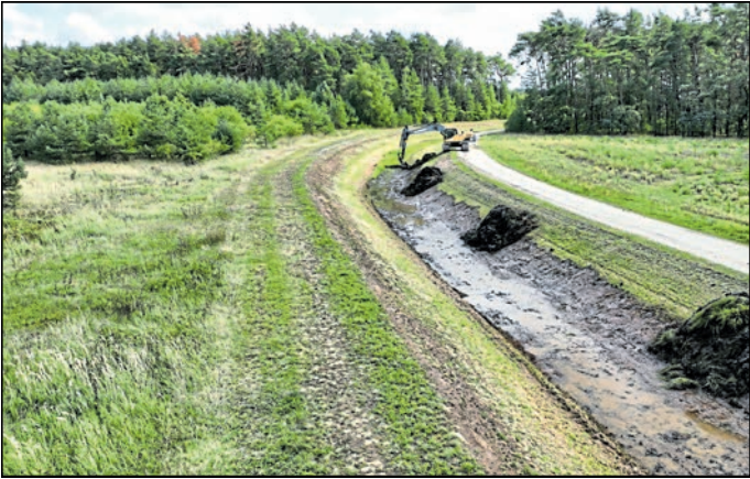
Von September bis November 2024 fanden Unterhaltungsarbeiten am Hoyerswerdaer Schwarzwasser statt. Foto: LTV/Robert Kölpin
