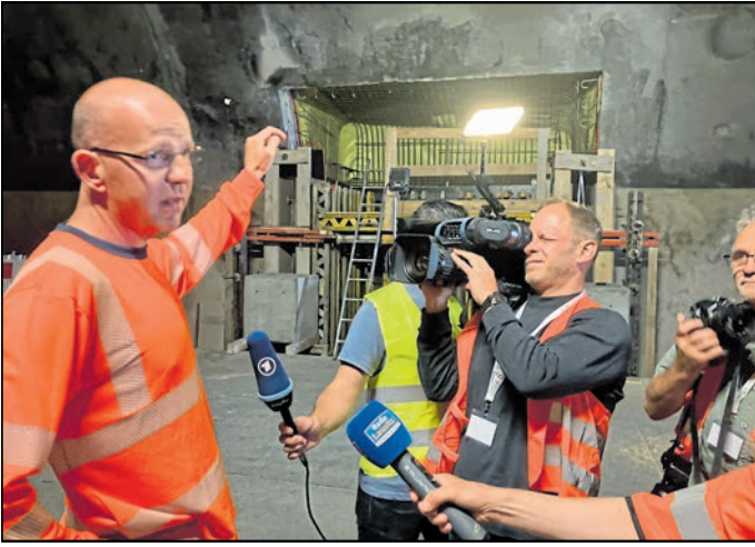
Das Vortreiben der Notruffnischen (hinten) im harten Granit verzögerte die Arbeiten zuletzt. Foto: Till Scholtz-Knobloch
